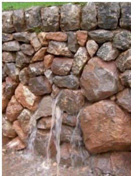
© C. Cornu – Mur en pierre sèche soumis à un écoulement
