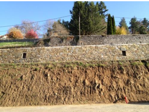
© H.H. Le – Mur de soutènement de Felletin, 2012
