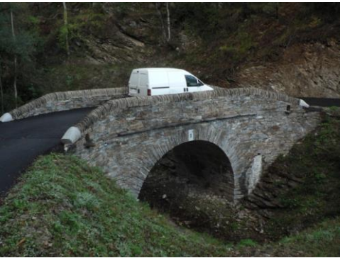
© A-S. Colas – Pont de Chaldecoste, 2011
