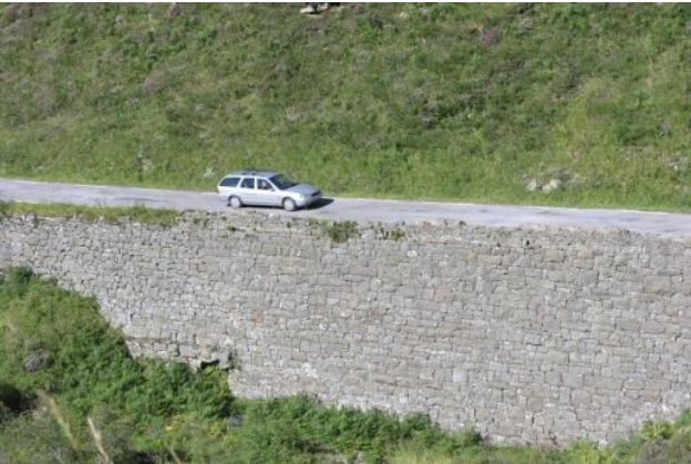
© C. Cornu – Mur de soutènement routier en pierre sèche
